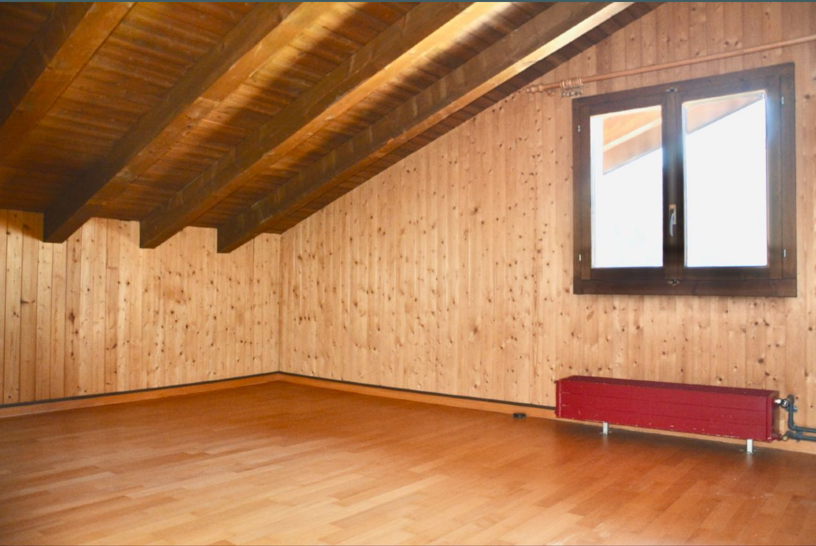
Dachgeschoss, Zimmer gegen Norden
